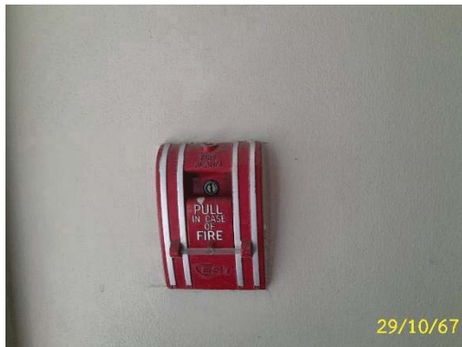
อุปกรณ์แจ้งเหตุเพลิงไหม้แบบมีอกด
