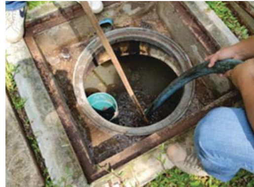
การสูบล้างส่วนเกินระบบบำบัดน้ำเสีย
