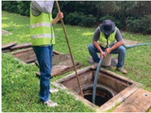
การสูบล้างส่วนเกินระบบบำบัดน้ำเสีย
