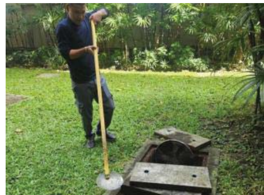
การตัดไขมันออกจากกระบบบำบัดน้ำเสีย
