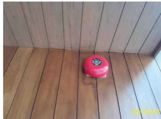
อุปกรณ์แจ้งเหตุเพลิงไหม้ด้วยเสียง (Alarm bell)
