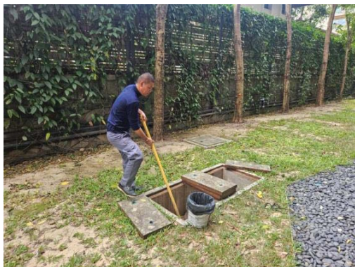
การตัดไขมันออกจากกระบบบำบัดน้ำเสีย
